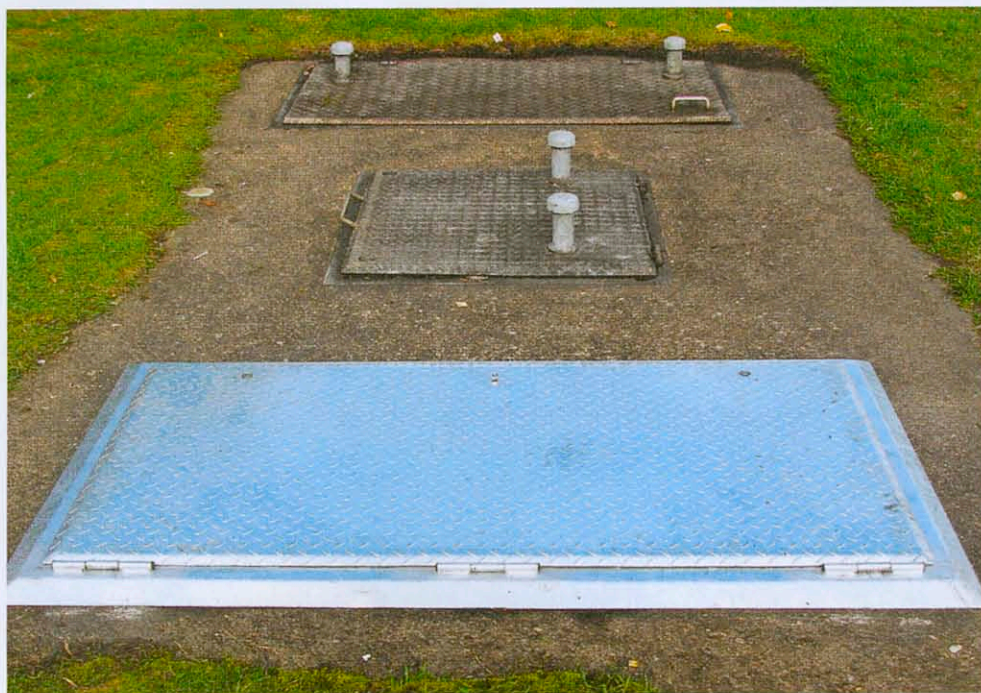
Die neue Abdeckung wird passgenau in den einbetonierten alten Rahmen eingebaut und mit Schrauben verspannt.
