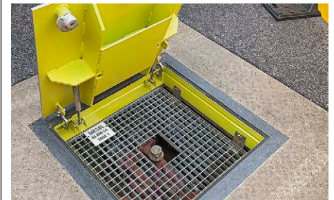
Schachtabdeckung mit Trittschutz Shaft cover with step protection
