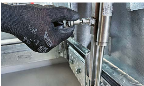
Nachrüstbare Deckelarretrierung Retrofittable cover locking mechanism
