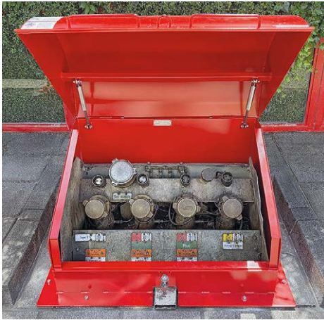
Das komplett ausgetauschte Fernfüllgehäuse in der Variante „Brotkasten“ The completely replaced remote-filling housing in the 'bread bin' version
