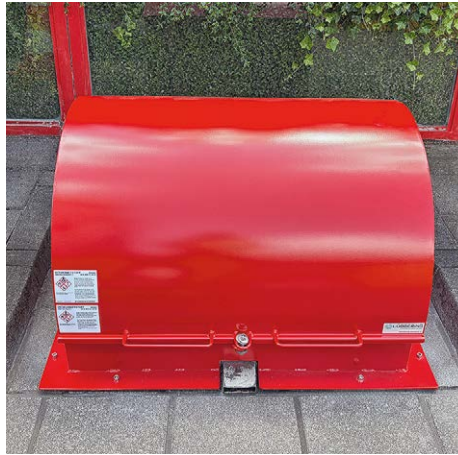
Das komplett ausgetauschte Fernfüllgehäuse in der Variante „Brotkasten“ The completely replaced remote-filling housing in the 'bread bin' version
